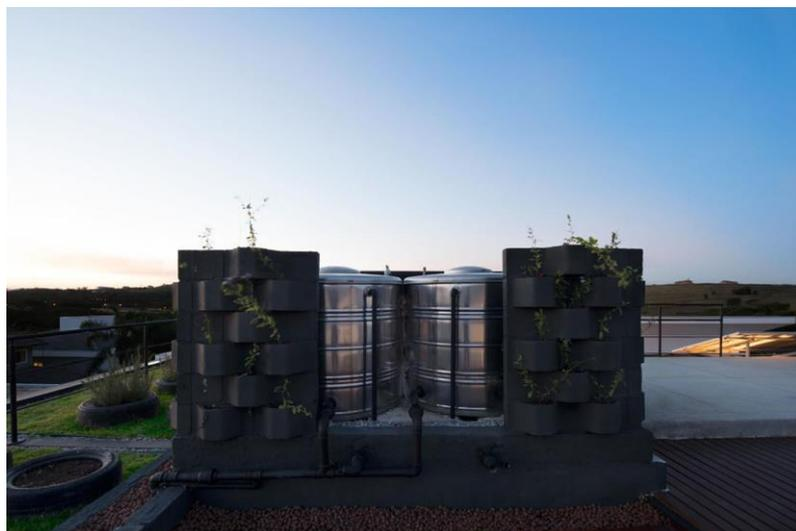
Figura 37: Cisternas na cobertura com telhado verde
