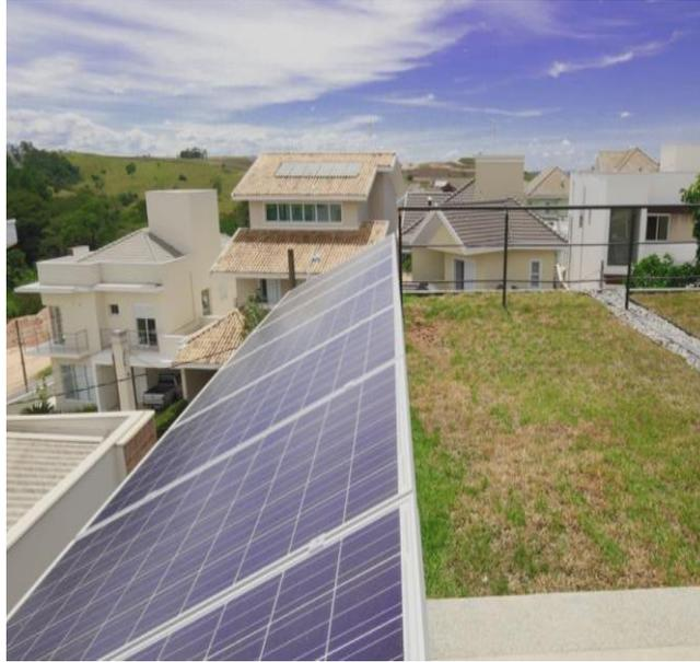
Figura 38: Placas fotovoltaicas na cobertura
