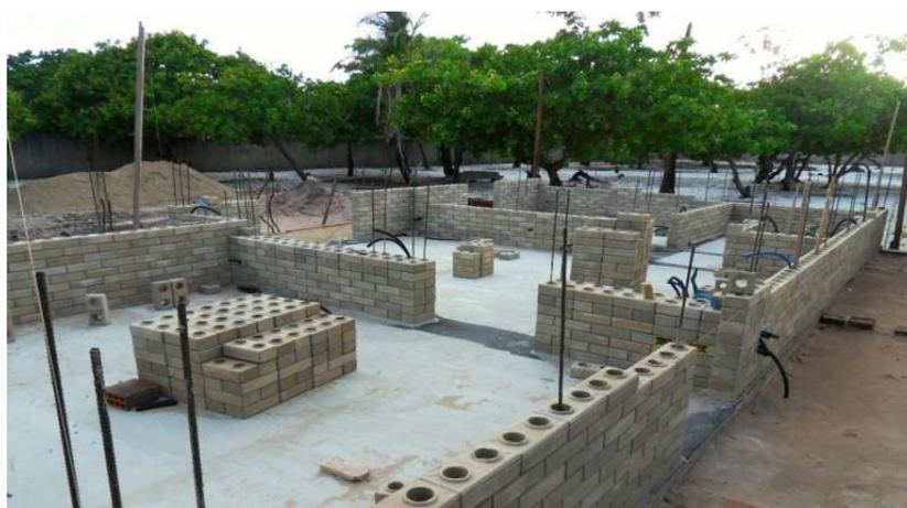
Figura 01: Tijolo Ecológico na construção
