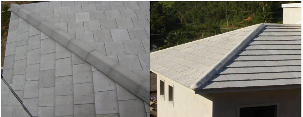
Figura 04: Telha de concreto instalada
